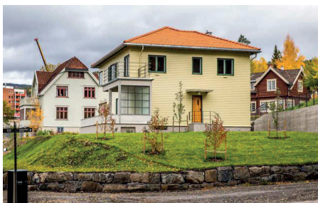
Paulsrud monterte dører og vinduer i Dronning Sonjas barndomshjem. Foto: Alexander Myklebust/GD
