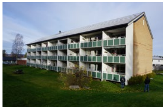
Før og etter oppgradering av balkongene i Bokfinkvegen Borettslag.
