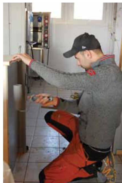
Travle dager med maling og oppussing.
