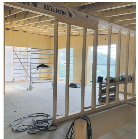
Det første huset er under oppføring.
